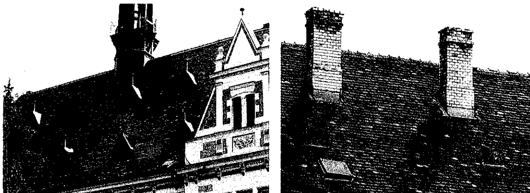
Foto 17 și 18 – Vederi ale „lucarnelor” de aerisire amplasate pe pantele dinspre stradă (f. stânga) și pe pantele dinspre curte ale acoperișului (f. dreapta)
