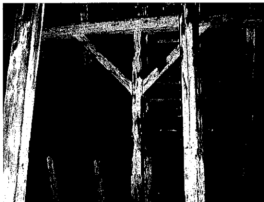
Foto 15 și 16 – Podul clădirii: - detaliu al structurii șarpantei din lemn (f. stânga) și ferma orizontală tip „vierendeel” de la nivelul cosoroabei (f. dreapta)
