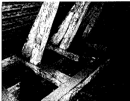
Foto 15 și 16 – Podul clădirii: - detaliu al structurii șarpantei din lemn (f. stânga) și ferma orizontală tip „vierendeel” de la nivelul cosoroabei (f. dreapta)
