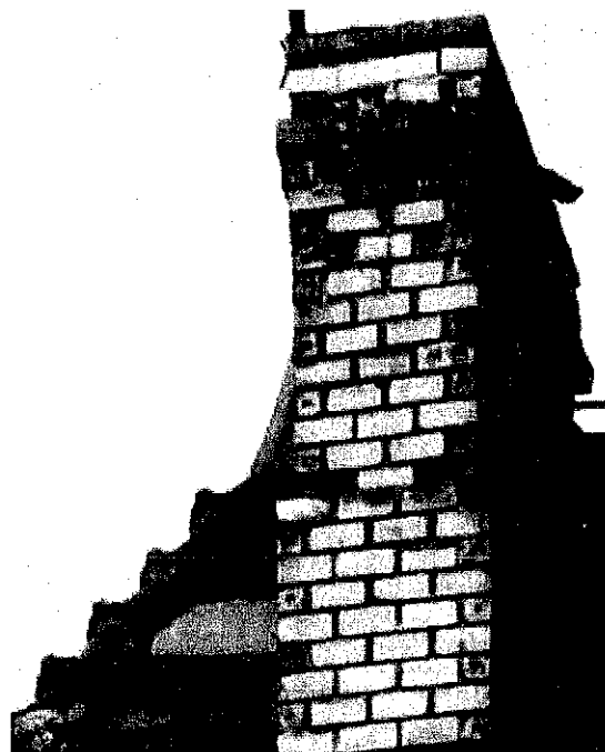
Foto 28, 29, 30, 31, 32 și 33 – Detalii de avariere și degradare a părții superioare a coșurilor de fum
