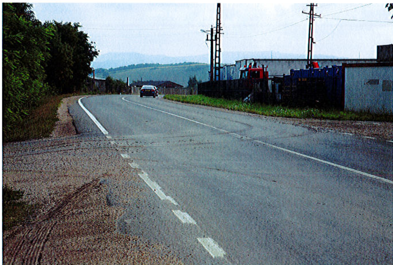
Fig. 68 Aspect al antrenării particulelor de pe drumurile vicinale neasfaltate, DJ 687.
